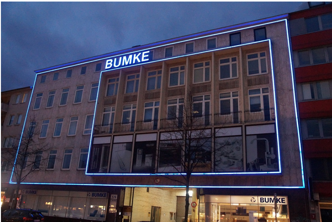
Abb.: Ansicht auf das Bumke-Haus vom E-Dammaus
